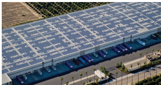
Solárne panely v Prologis Park Redlands v Kalifornii s certifikátom LEED Silver.
